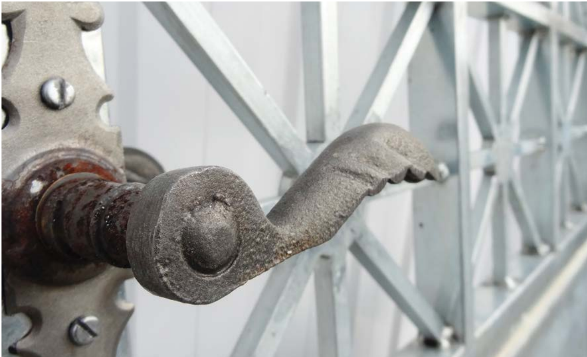
Portón metálico decapado por inmersión.
