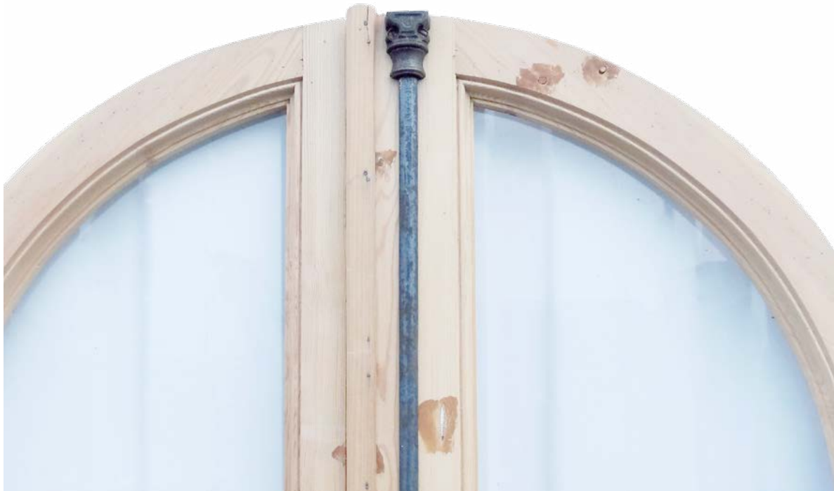
Detalles de puerta ventanal antigua decapada.
