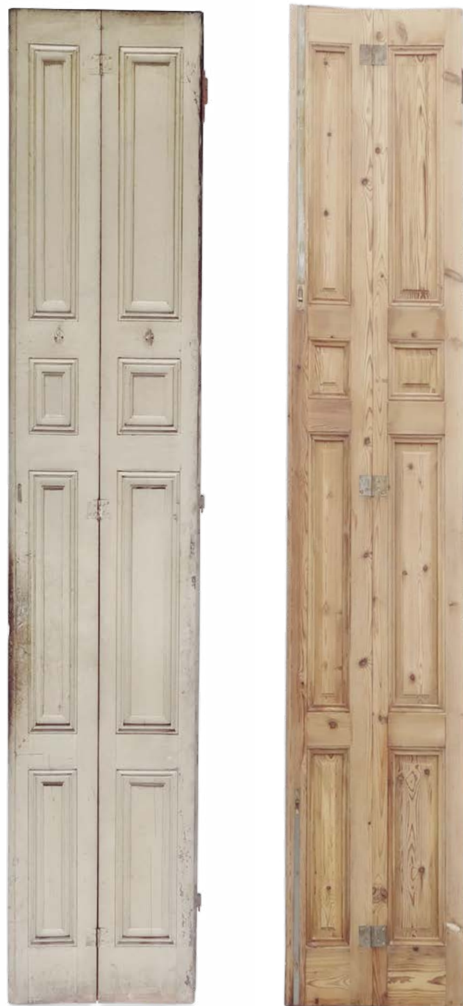
(Izda.) Contraventana antes y después de decapar por inmersión. (Dcha.) Detalle de contraventana antes y después de decapar por inmersión.
